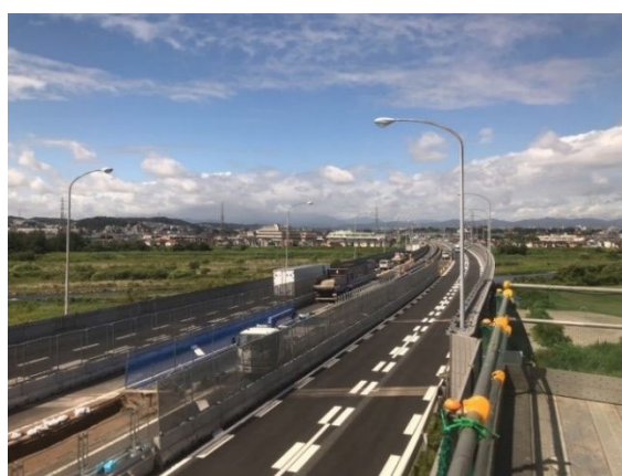
【E20 中央自動車道多摩川橋での床版取替工事】
