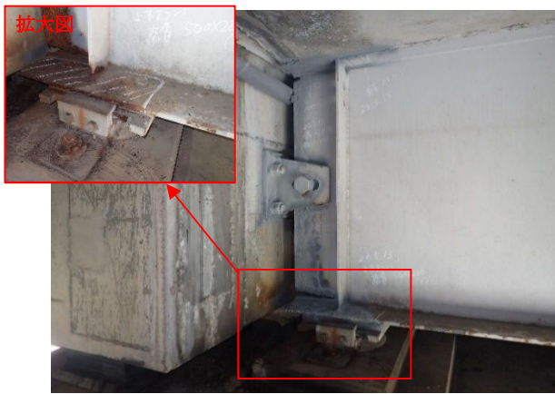
【判定区分Ⅲとした施設の修繕事例 橋梁上部工等の損傷(E84 新湘南バイパス 赤羽根高架橋)】
