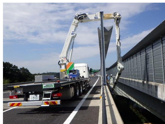
【遮音壁の点検実施状況】
