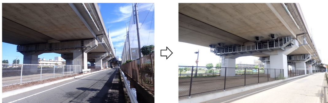
【橋脚の耐震補強および落橋防止装置の設置(E84 新湘南バイパス 西久保高架橋)】
