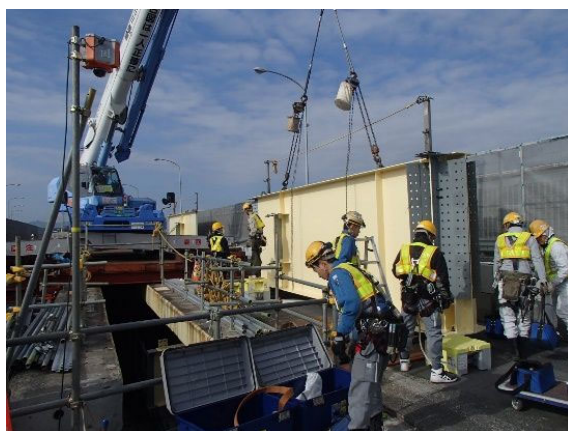
【E20 中央自動車道多摩川橋での床版取替工事】
