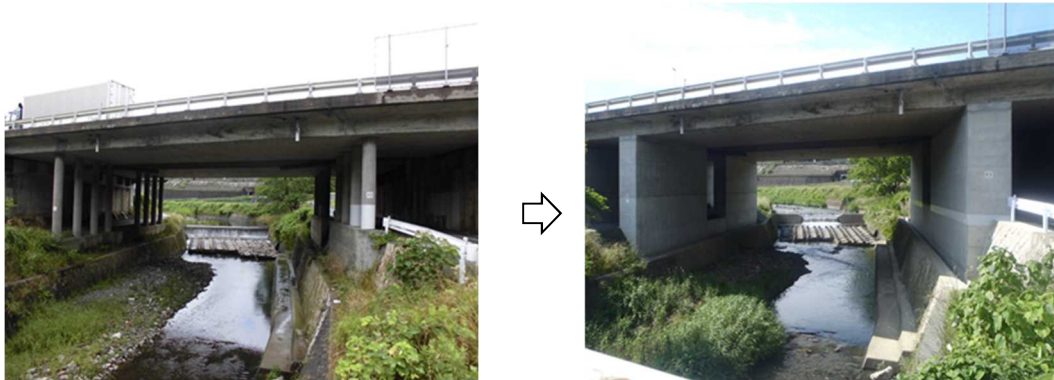
【E1 名神高速道路 ロッキング橋脚耐震対策状況】
