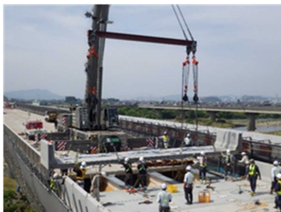
【E8北陸道 床版取替工事】
