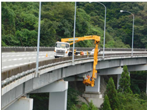
【橋梁の点検実施状況】
