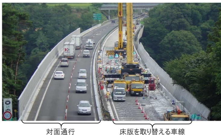
【従来工法による床版取替工事】
