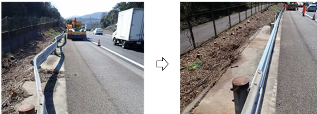
【交通事故復旧作業状況】
