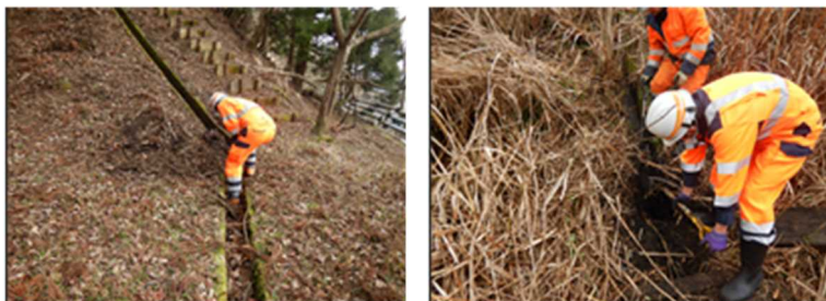
【のり面排水溝清掃状況】
