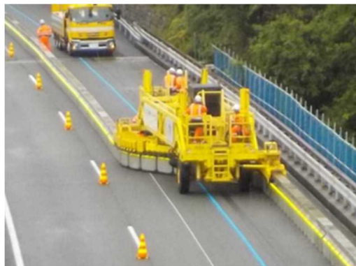
【移動式防護柵の設置状況】
