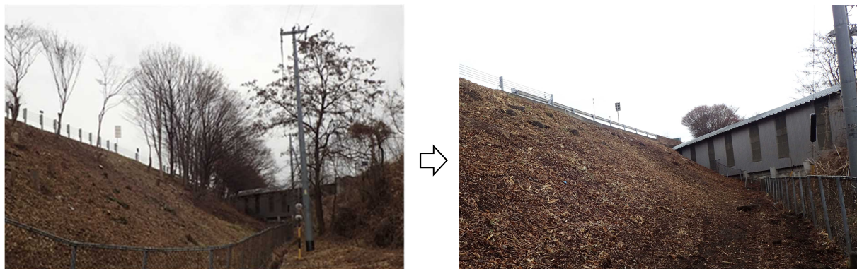
【生育不良木等の伐採状況】
