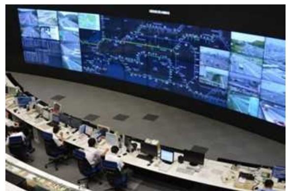
【道路管制センター】
