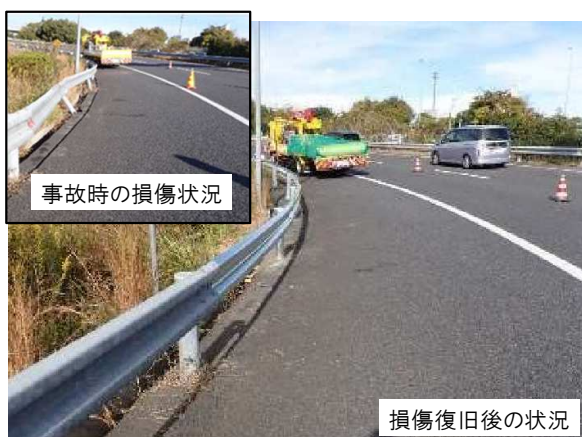
(事故復旧の状況)
