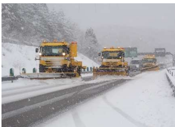
(除雪作業の状況)
