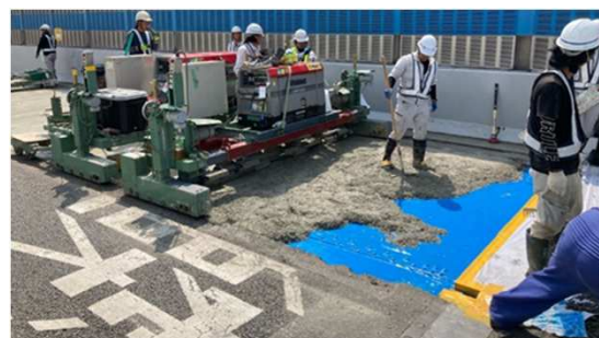
(鋼繊維補強コンクリート(SFRC)舗装の施工状況)
