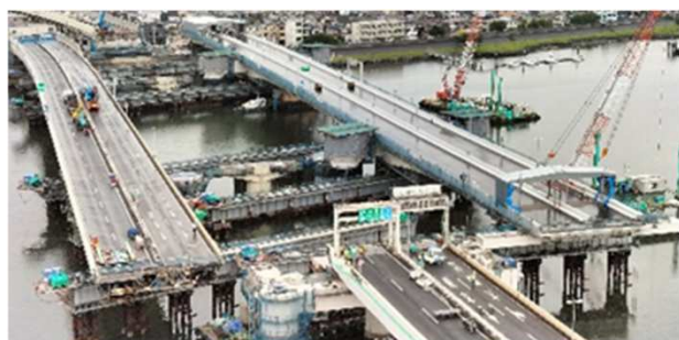
(新設橋への架替の状況)
