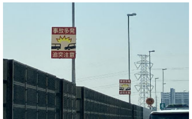
(注意喚起看板の設置状況)
