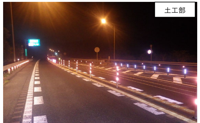
(ワイヤロープの設置状況)
