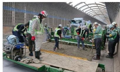
(鋼繊維補強コンクリート(SFRC)施工状況)
