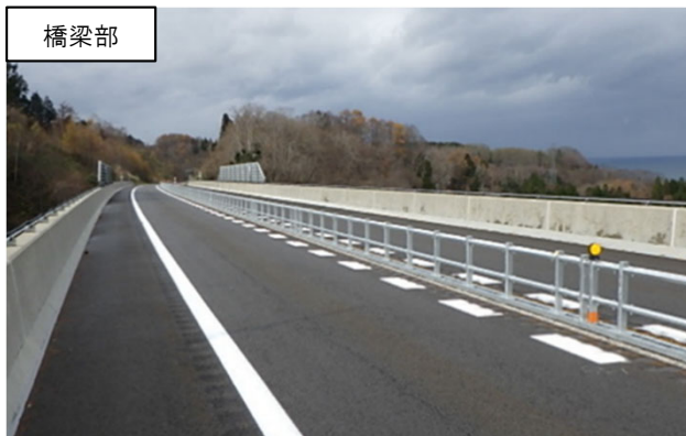
(センターパイプの設置状況)
