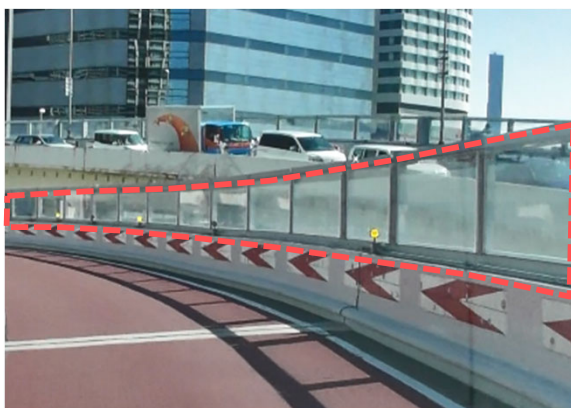
(二輪車落下防止対策の状況)
