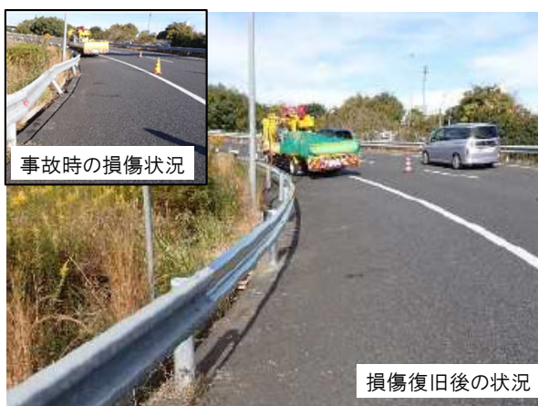
(事故復旧の状況)
