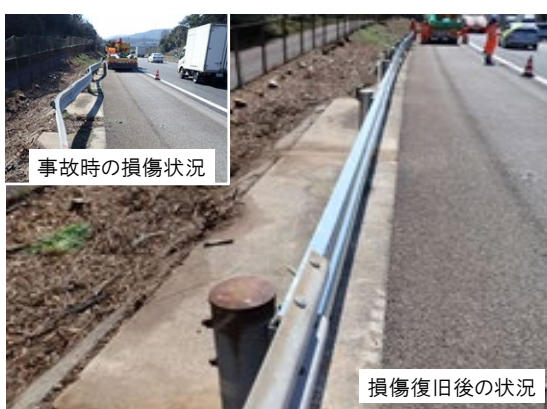
(事故復旧の状況)
