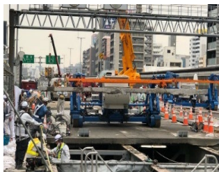
(超高強度繊維補強コンクリート床版の工事の状況)
