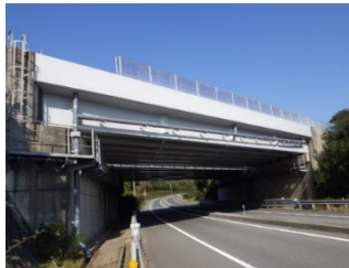
(表面被覆工の状況)
