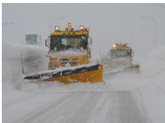
(除雪作業の状況)
