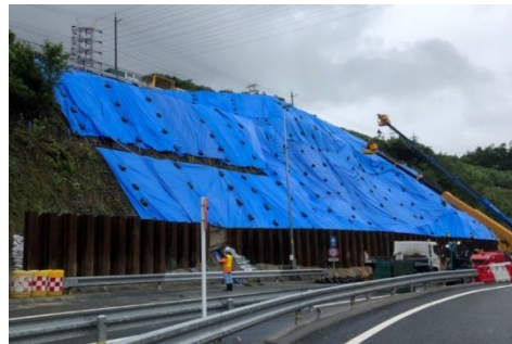
(斜面崩落の応急復旧の状況)
