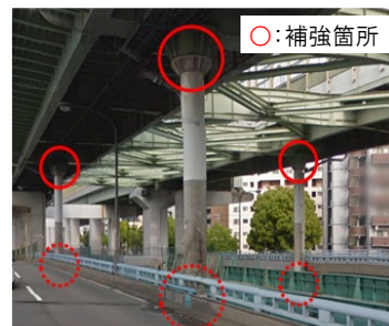
(ロッキング橋脚の耐震補強)
