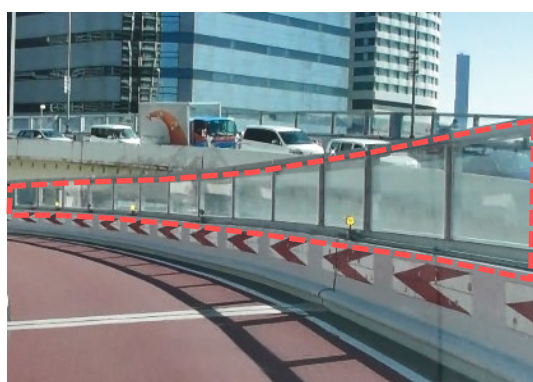
(二輪車落下防止対策の状況)
