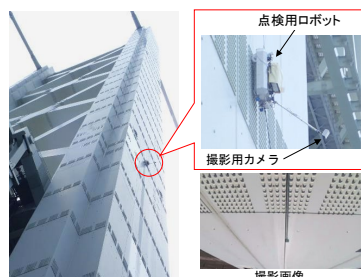
(高所点検用ロボットの検討)
