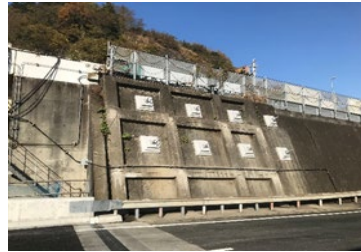
(のり面補強工事の状況)
