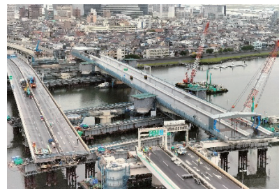
（新設橋への架替の状況）
