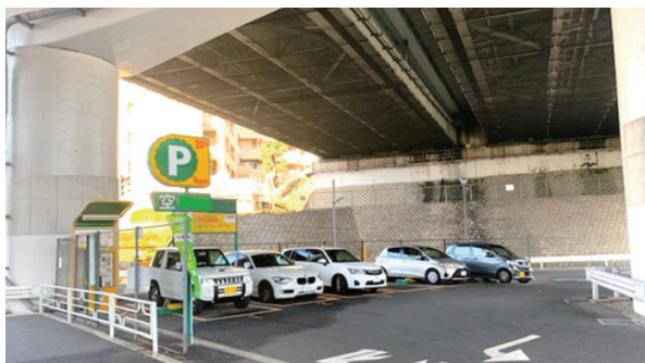
駐車場（高架下）
