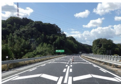
路面標示による速度抑制対策
