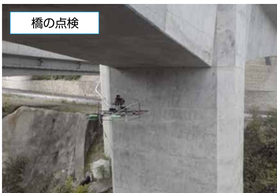
ドローンによる点検状況
