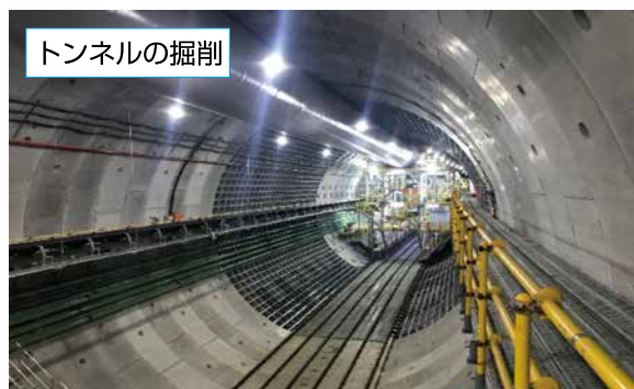
トンネルの掘削 都心の地中深くを掘り進みます
