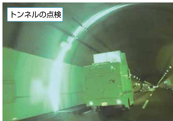
移動式トンネル点検車による点検状況
