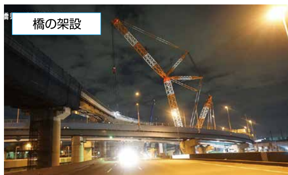
橋の架設 高速道路の通行を止めて一気に橋を架けます
