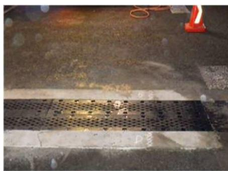
補修後（伸縮装置の取替え）
