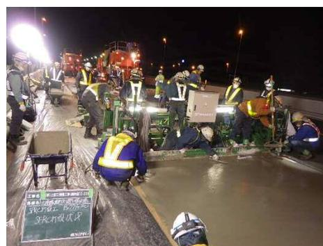
鋼床版 SFRC 舗装施工状況
