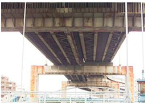
補修前（鋼構造物の塗装劣化）
