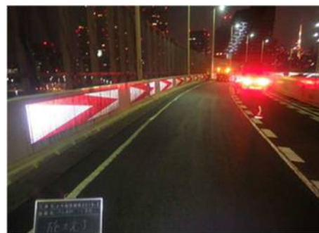
補修後（鋼床版部舗装の打換え）
