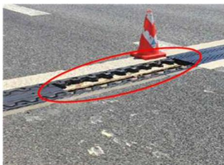
補修前（伸縮装置の破損）
