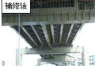
劣化した既設の塗膜を除去し、耐久性の高い塗料を用いて被覆補修を行うことで、従来よりも防食性能が向上します。
