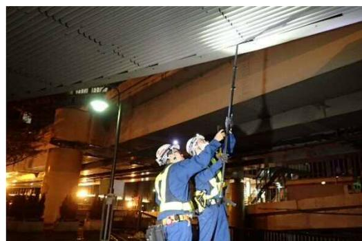
簡易型高所点検用ポールカメラによる点検
