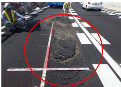
補修前（鋼床版部舗装の損傷）
