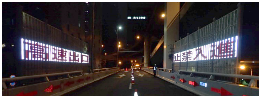
(逆走車両に対して、より明確に逆走を周知する看板の設置)
