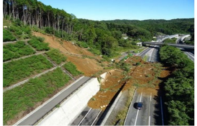
(圏央道 八王子西インターチェンジ 付近での斜面崩落)
