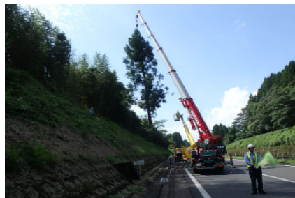
(樹木伐採の状況)
