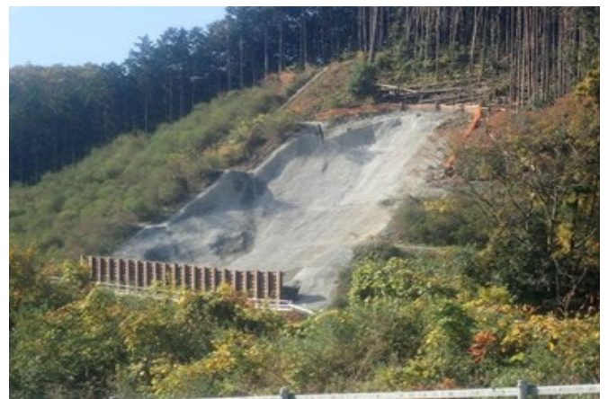
(斜面崩落の応急復旧の状況)
