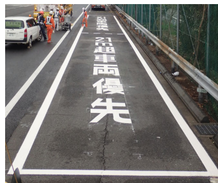
(ダブル連結トラック用エリア)
