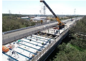
(床版取替え工事の状況)
