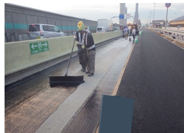
(床版防水工事の状況)
