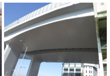
(表面被覆工事の状況)
