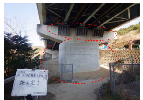
(橋脚の耐震補強：左が対策前で右が対策後)
