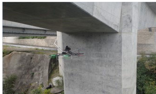
(ドローンによる点検状況)
