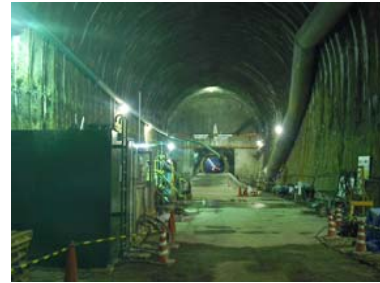
③シールド転回部付近
