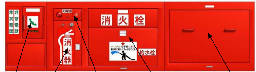
非常電話 消火器 押しボタン式通報装置 消火栓・給水栓 水噴霧自動弁収納箱 (将来設置)
