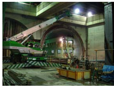
②シールド発進立坑内
