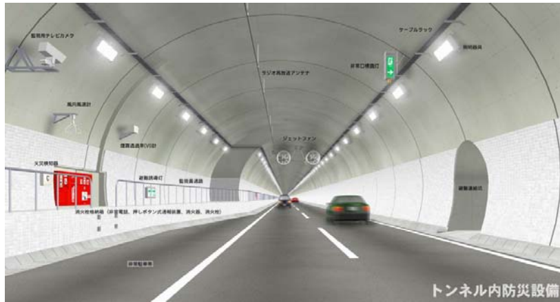
非常電話 消火器 押しボタン式通報装置 消火栓・給水栓 水噴霧自動弁収納箱 (将来設置)
