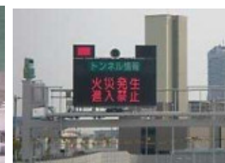
トンネル入口警報板
