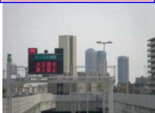
トンネル入口警報板
