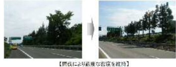
【積雪により遮蔽ら窓保護を維持】
