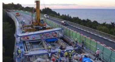
【高速道路リニューアル工事 橋梁床版取替工事の状況】
