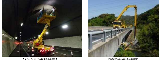
【トンネルの点検状況】 【橋梁の点検状況】
