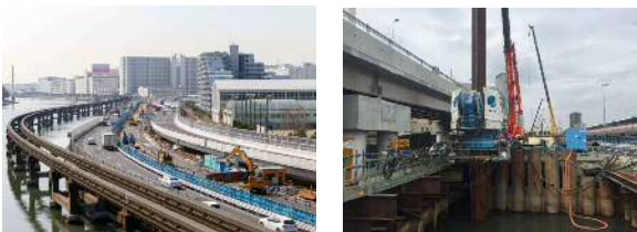
【首都高速1号羽田線 東品川栈橋・鮫洲埋立部更新工事の状況】
