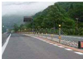
【ワイヤロープ式中央分離帯防護柵設置状況】
