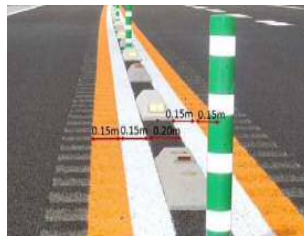
【凹凸レーンマーク施工状況】
