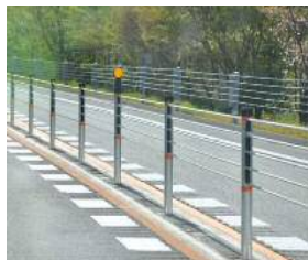
【ワイヤロープ式中央分離帯防護柵設置状況】
