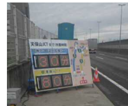
【工事区間及び迂回ルート掲出状況】
