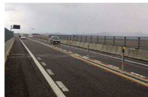
【ワイヤロープ式中央分離帯防護柵（中小橋）施工状況】
