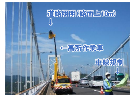
海峡部橋梁上のメンテナンスの様子
