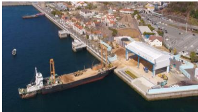
海上運搬拠点(接岸)状況
