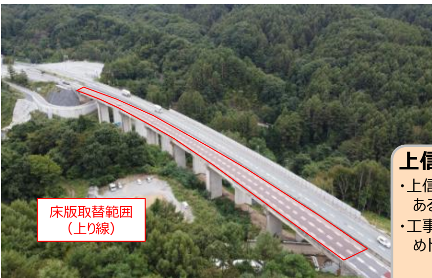
現場全景写真(香坂川橋)
