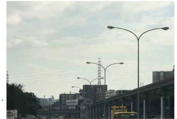
道路照明設置状況 (吹田JCT～宝塚IC間)
