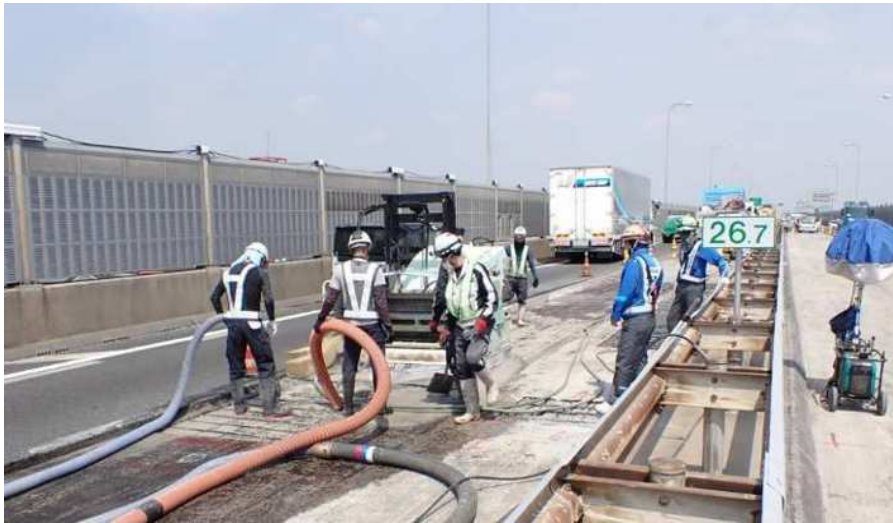
昼夜連続・車線規制による工事状況(2022年度名二環集中工事)
