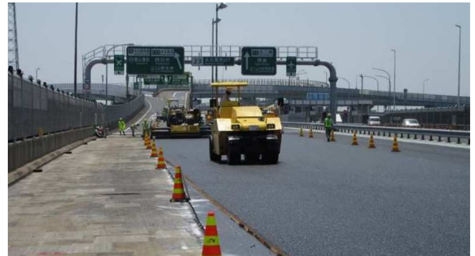
昼夜連続・通行止めによる工事状況(2023年度名二環集中工事)
