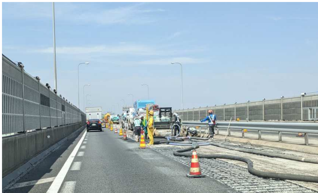
昼夜連続・車線規制による集中工事状況
