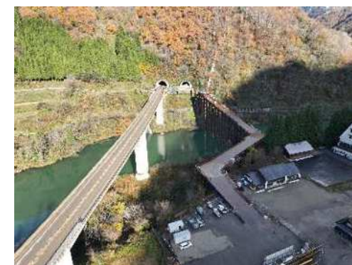
工事用仮橋設置状況
