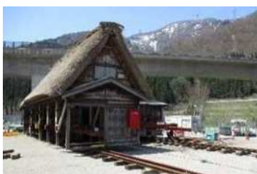
総合案内所移設状況
