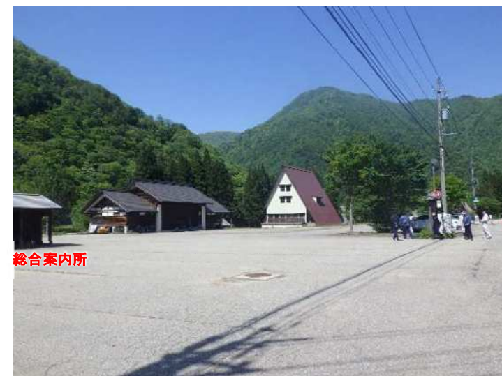
五箇山合掌の里 駐車場(工事前)
