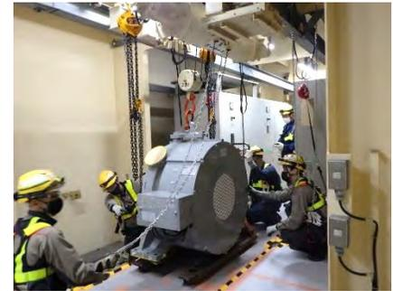
④電動ホイス(2t吊)で横引き補助しながら台車を昇降路まで移動
