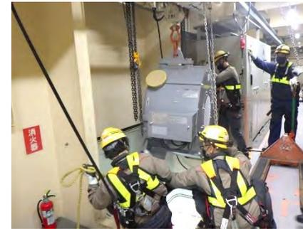
③20階の下部水平材の台車上に吊上げた機器を載せる
