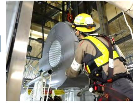
⑥昇降路内の電動ホイス(2t吊)で機器を吊上げ
