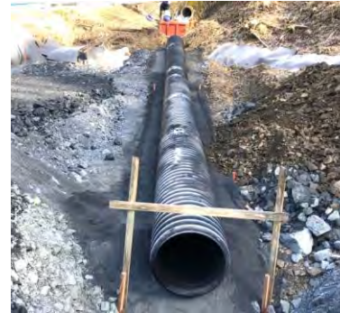
地下排水設置状況
