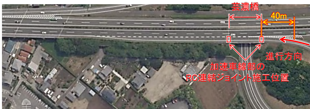
芸濃橋(上り線)航空写真
