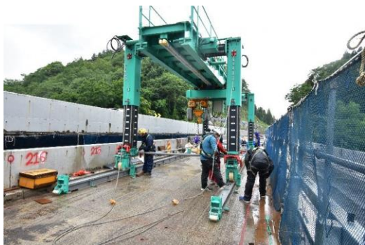
架設機械(門型クレーン)
