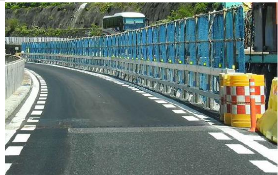
鋼製防護柵 現地設置状況
