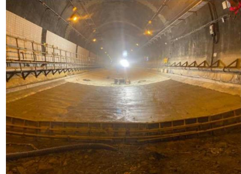
[全断面掘削によるインバート設置状況]
