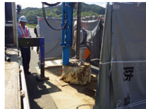
④ 支柱設置箇所の掘削
