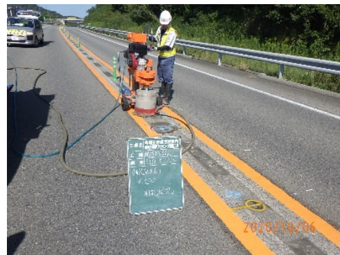
③ 支柱設置箇所の舗装撤去
