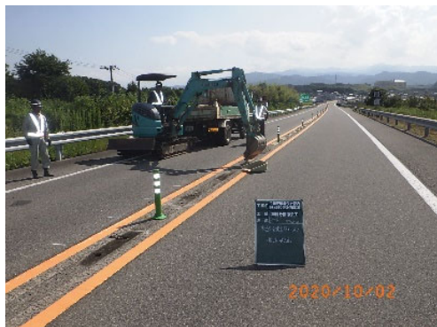
② 既設縁石撤去
