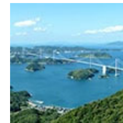
来島海峡第一・第二・第三大橋
