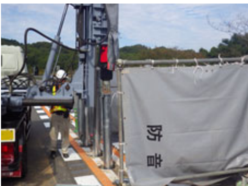
⑤ ワイヤ固定箇所の基礎杭打込み
