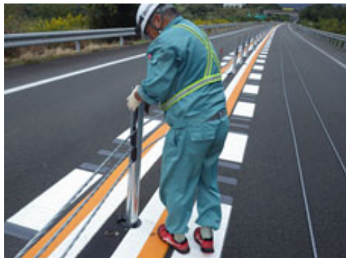
⑥ 支柱・ワイヤロープ設置
