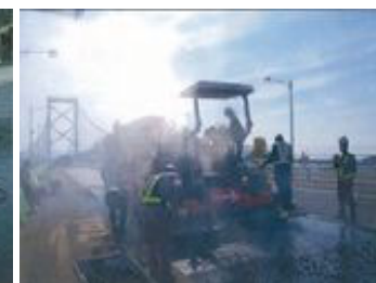
《基層グースAS舗設》
