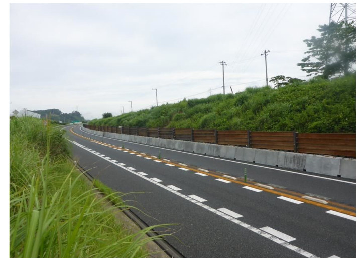
落石防護柵設置状況
