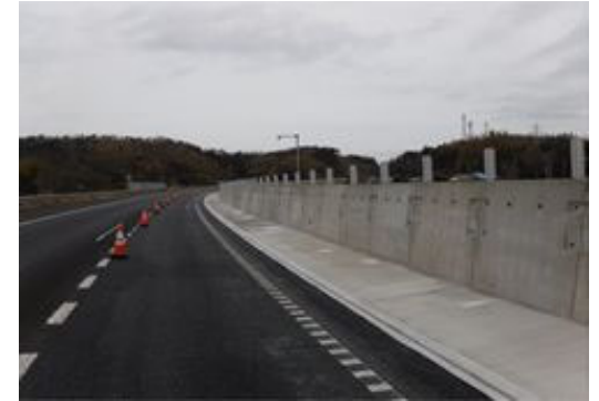
中央分離帯防護柵の設置状況
