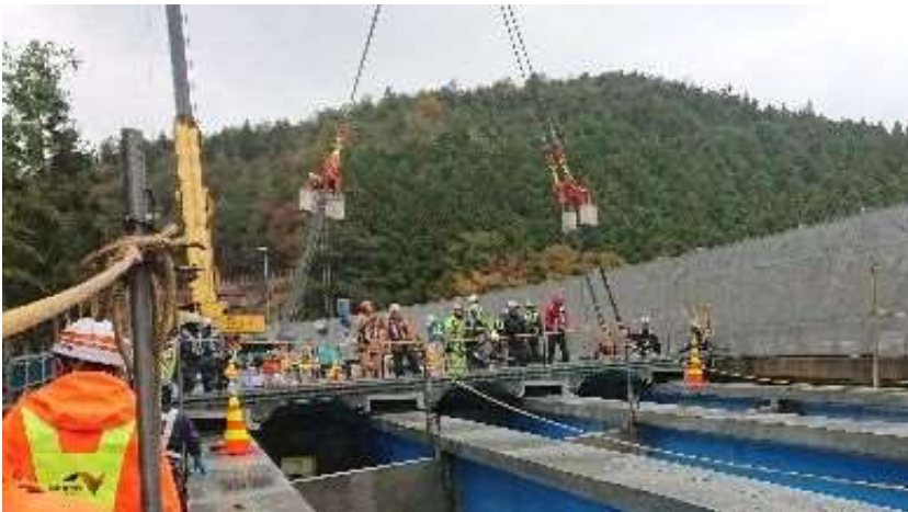
キャップスラブ工法による施工
