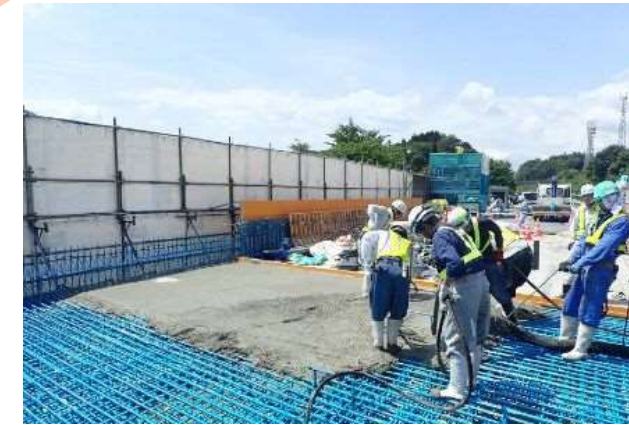
現場打設による床版打替(例)
