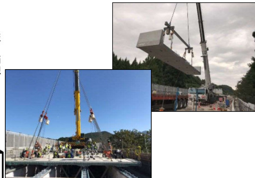
トラッククレーン施工(例)
