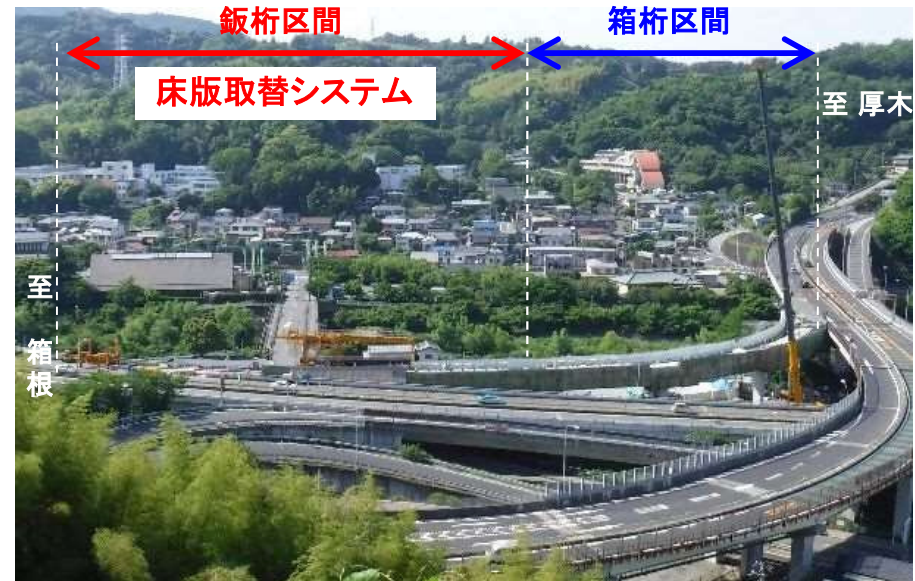
2区間同時施工
