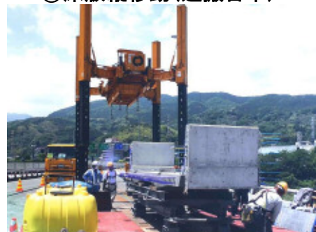
②床版縦移動(運搬台車)
