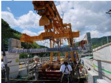
④床版据え付け(床版取替機)
