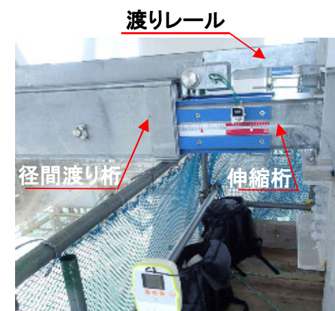
実橋実験による伸縮確認等の状況
