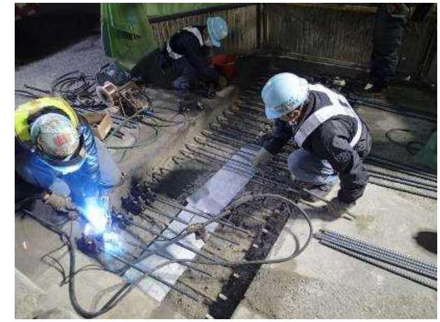
床版連結(上側鉄筋のみ接続)
