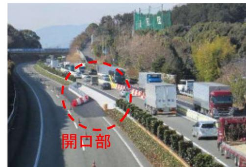
緊急時に開口できる構造
