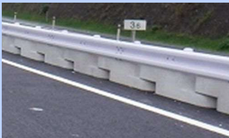
置き式ガードレール設置状況
