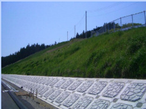
コンクリートのり砕工
