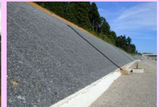
碎石のり面工
