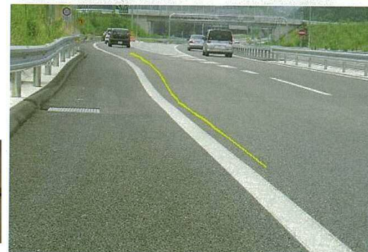
路面の沈下状況例(紀勢道)
