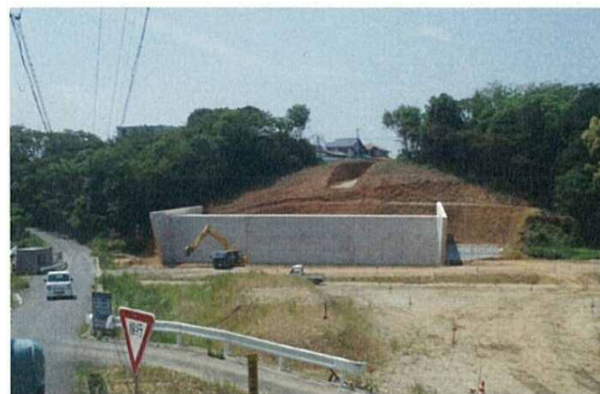
県道豊川新城線の盛土施工状況
