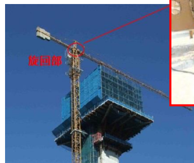
タワークレーン旋回時の安全対策
