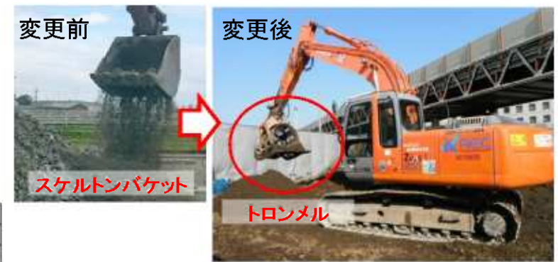
筒状の回転式ふり分け機による振動対策
