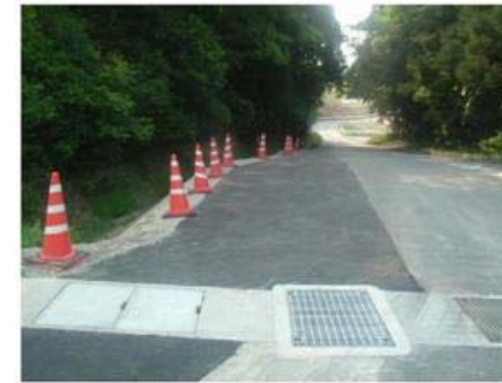
隅切り部を拡幅した桁搬出路
