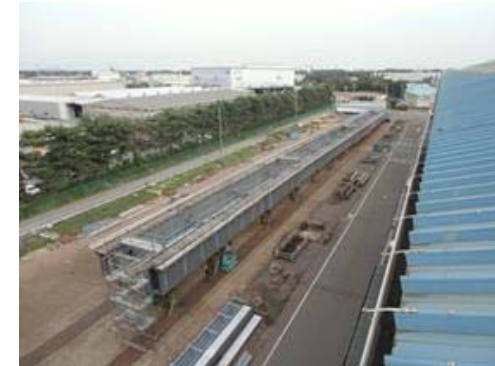
川北橋 仮組立状況
