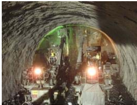
トンネル掘削
