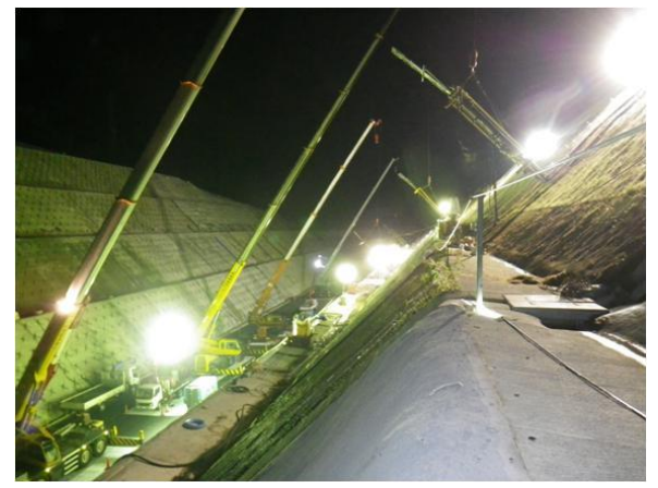
グランドアンカー工施工状況
