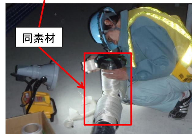
ポリアリレート繊維を巻いたポリエチレン分岐継手
