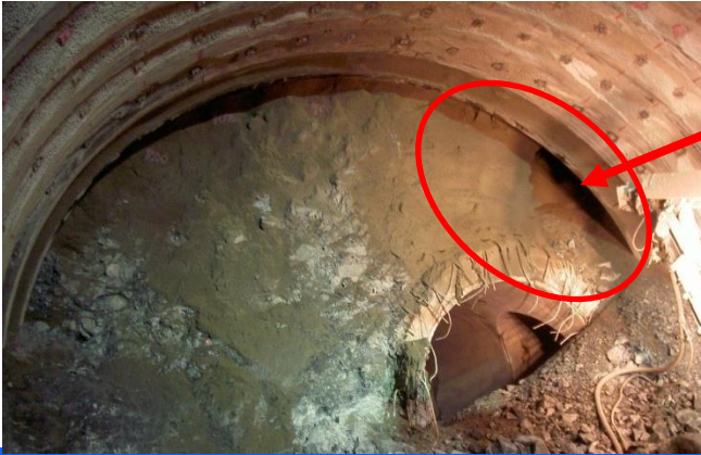
土砂化した箇所からの崩落
