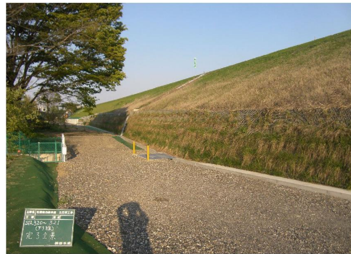
盛土完成写真
