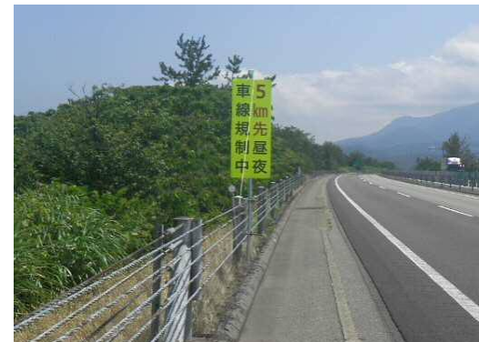
工事予告看板(5km手前)
