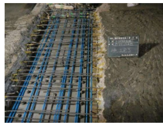
既設鉄筋と新設鉄筋を溶接により接合するため、施工時間が長い
