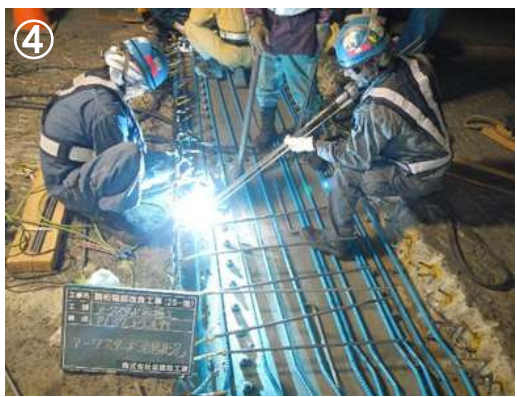
既設鉄筋と新設鉄筋を溶接により接合するため、施工時間が長い
