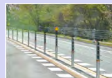
ワイヤロープ設置
