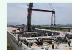
床板取替え工事
