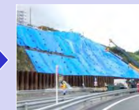
応急復旧の状況
