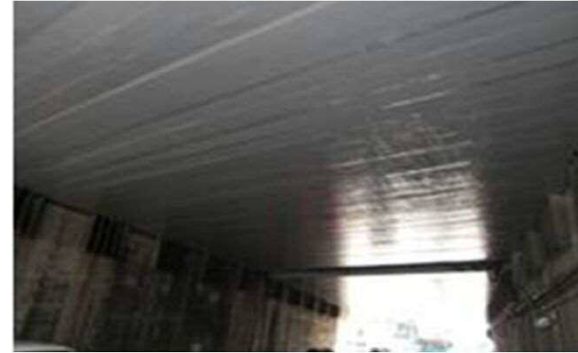
橋梁の補強(繊維シート床板補強)
