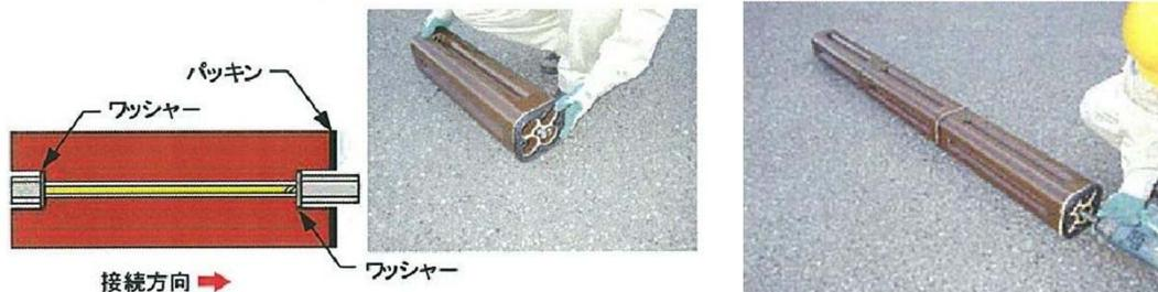
全長600mmの陶管をナット付ボルトにより、順にインパクトレンチで接続
