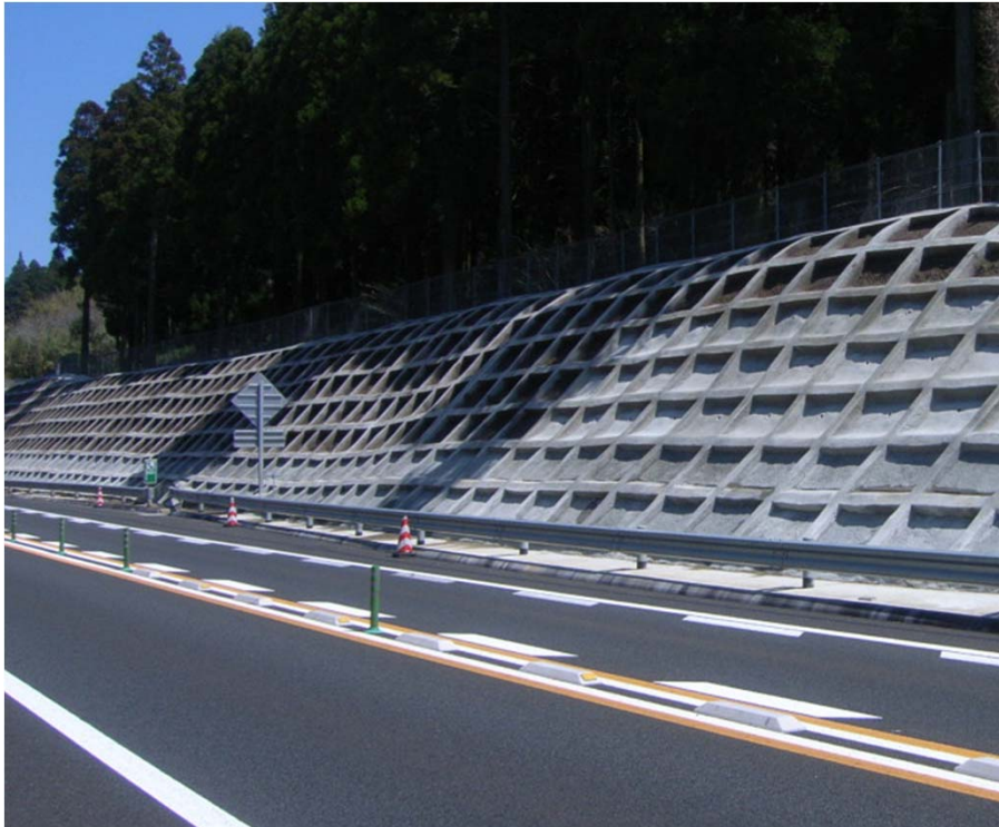
(当初)コンクリート吹付け枠工
