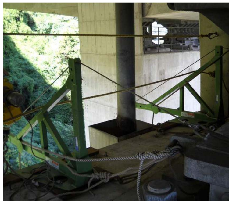
突梁設置及び落下防止ワイヤー設置
