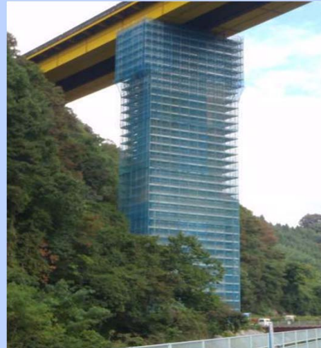
一般構造物用足場を設置した例
