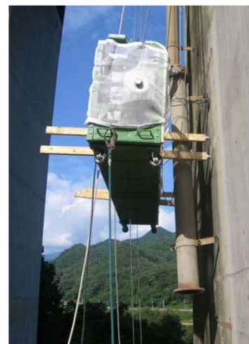
ゴンドラ工法による排水管取替えの状況
