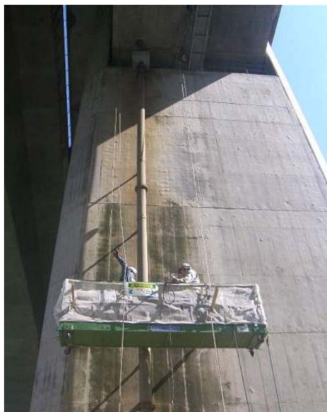
ゴンドラ工法による排水管取替えの状況
