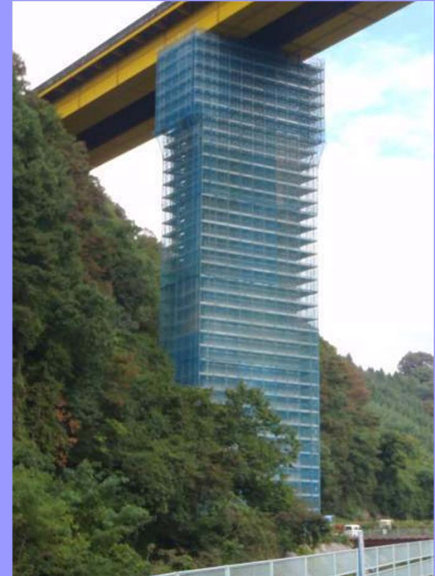
一般構造物用足場を設置した例
